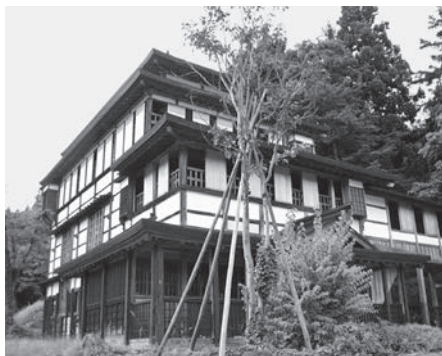
旧長谷山邸。鞘堂に覆われた三階建ての蔵は明治期に建造されたもの。
